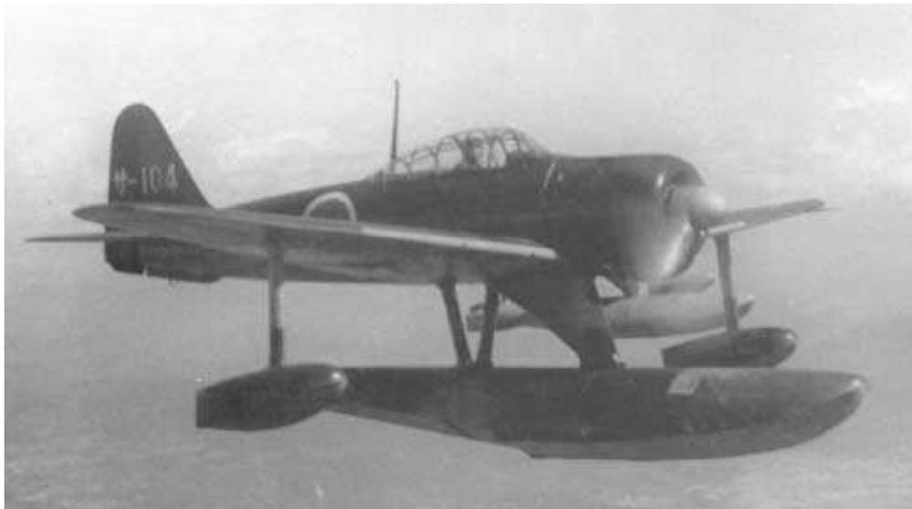
A6M2-N "Rufe": Versión hidroavión del "Zero", flotador central, y dos auxiliares estabilizadores
